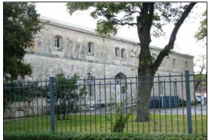
Vista hacia el Arsenal mostrando la cerca del perímetro.
