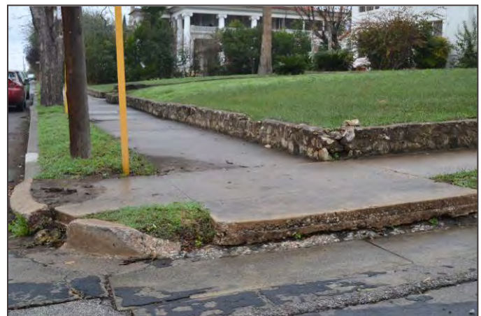
Curva de la acera y muro contenedor históricos en W. French Place y Belknap Avenue.
