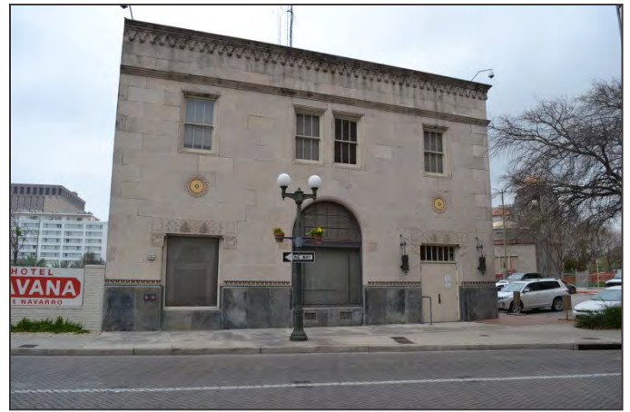
Edificio histórico Martin Wright, fachada del sur, Distrito Histórico Auditorium Circle. Note la iluminación histórica de la calle.
