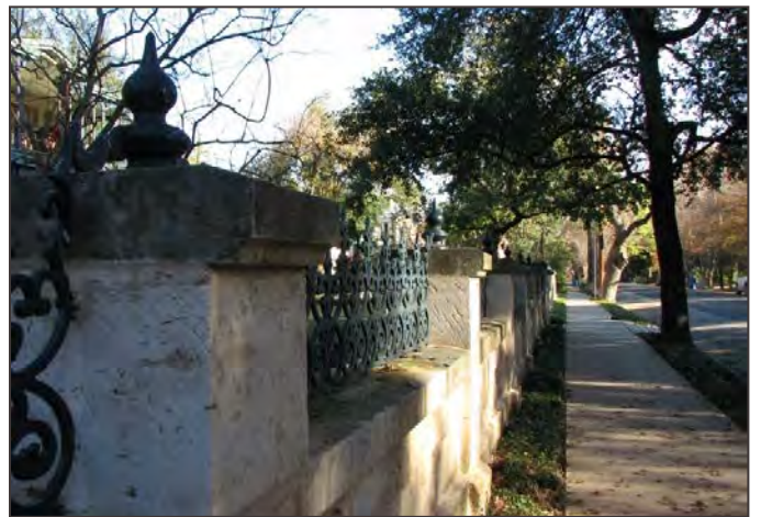
Muro de piedra con detalle de hierro forjado, Distrito Histórico de King William.
