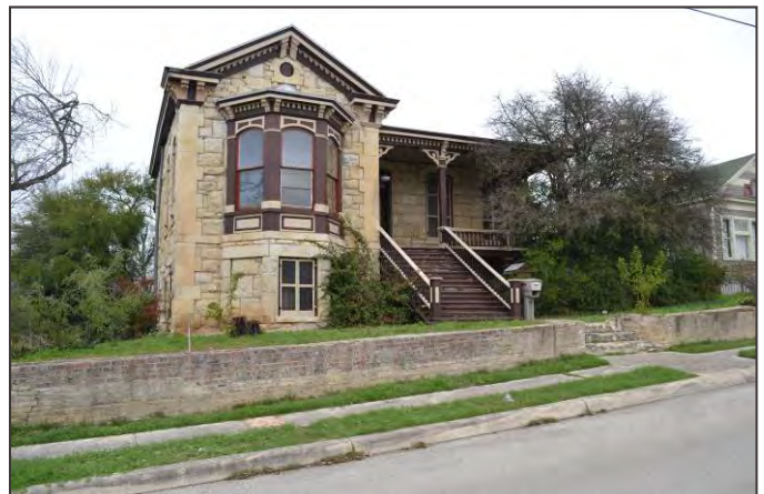
Muro de contención, cuadra 500 de la calle Burleson.
