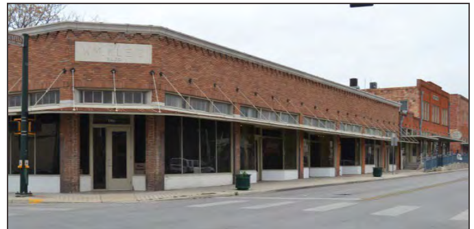
Edificaciones comerciales a lo largo de la Avenida New Braunfels, Distrito Histórico de Government Hill.
