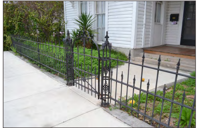
Cerca de hierro forjado, Distrito Histórico Lavaca..
