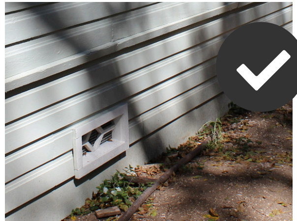
En la imagen: Zócalo de madera de reemplazo para que coincida con el revestimiento original
